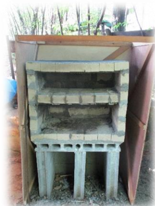
③金網を置き、その上にさらにレンガを並べます。
