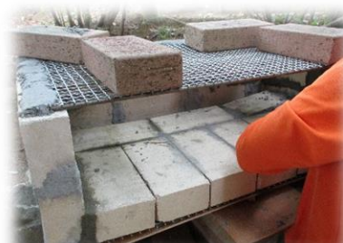
③金網を置き、その上にさらにレンガを並べます。
